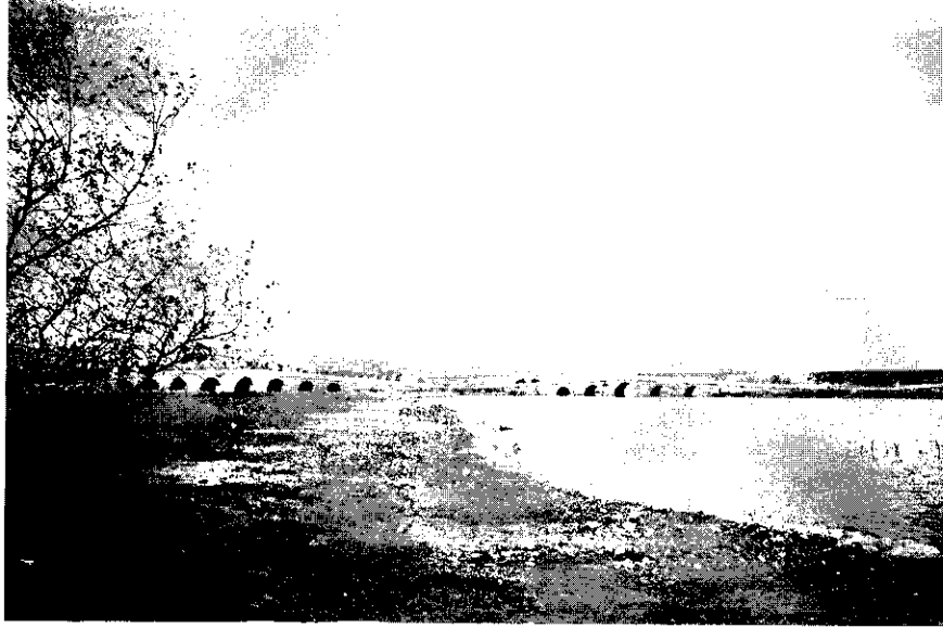
Foto 1: Mimar Sinan Köprüsü ve Doldurulan Alan
