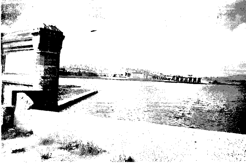
Foto 9: Mimar Sinan Köprüsünden B.Çekmece Baraj Seddi
